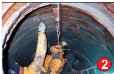
2. După astuparea scurgerilor active cu ENECRETE® WP, se aplică pe pereți două straturi de WS - sistem de etanșare
