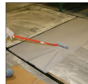
SuperBond™ este un grund tolerant cu suprafața, având o fereastră extinsă supraacoperire.
